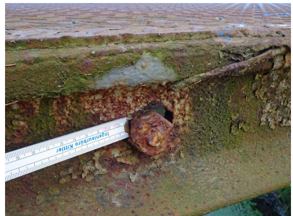
S09 ÜBERBAU AUSSTEIFUNG LOCKER
