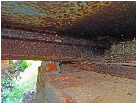
S04 LÄNGSTRÄGER VERROSTET
