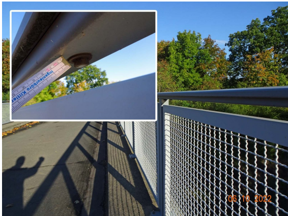
S54 HANDLAUF BEFESTIGUNGSSCHRAUBE
