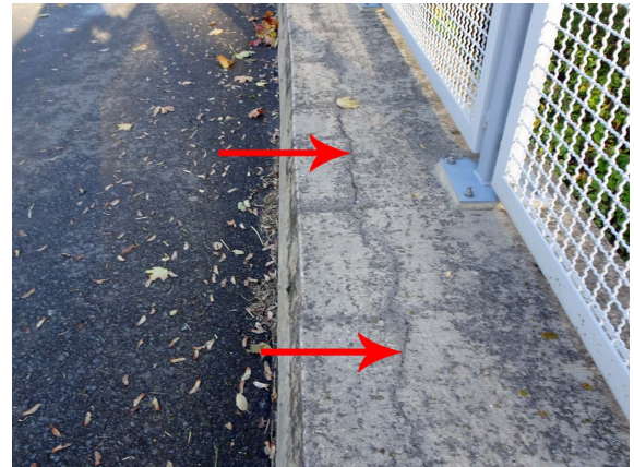
S46 KAPPE UND FLÜGELKAPPE_ LÄNGSRISSE
