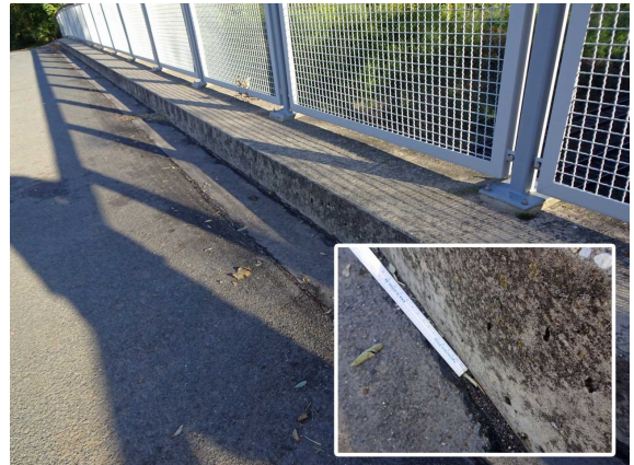
S24 FUGENDICHTUNGSMATERIAL NICHT HAFTEND
