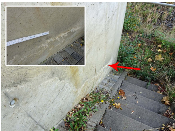
S53 AUSSINTERUNG AN FLÜGELWAND
