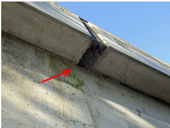
S47 FLÜGELWAND AUSSINTERUNG
