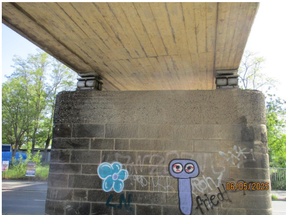
Bild 06 – Ansicht Pfeiler und Rollenlagerung
