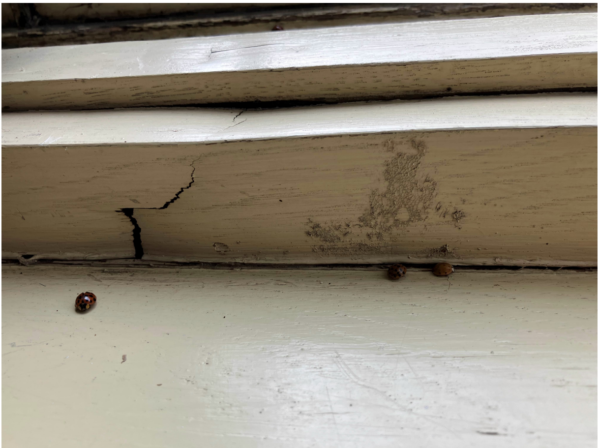
Fensterbrett und Fensterrahmen innen
