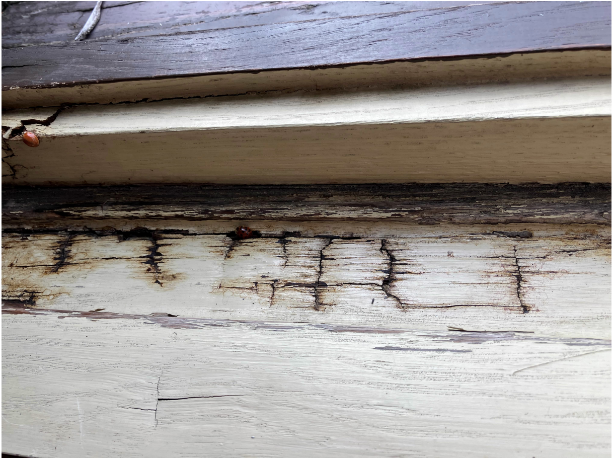
Fensterbrett und Fensterrahmen innen
