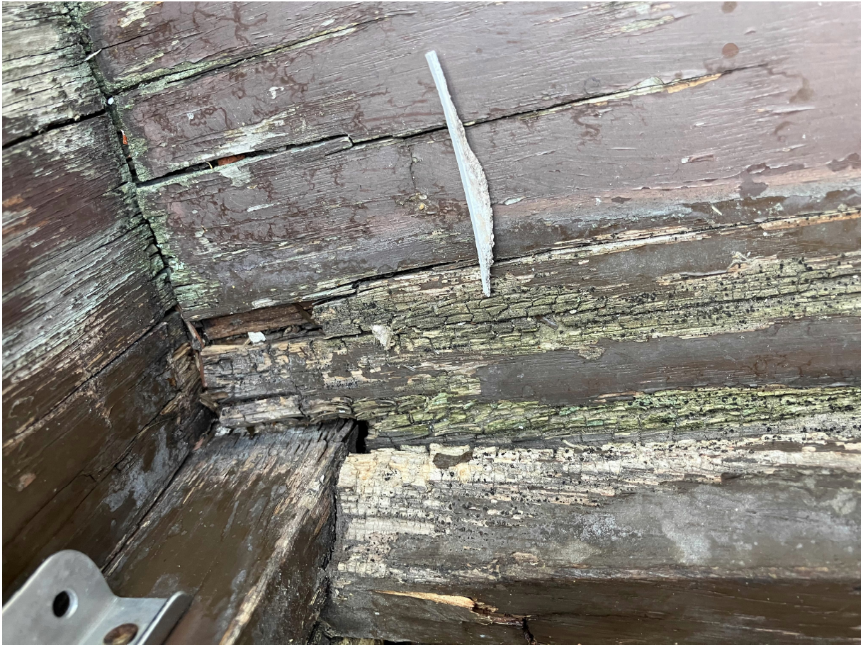
Fensterrahmen und Fensterbrett außen
