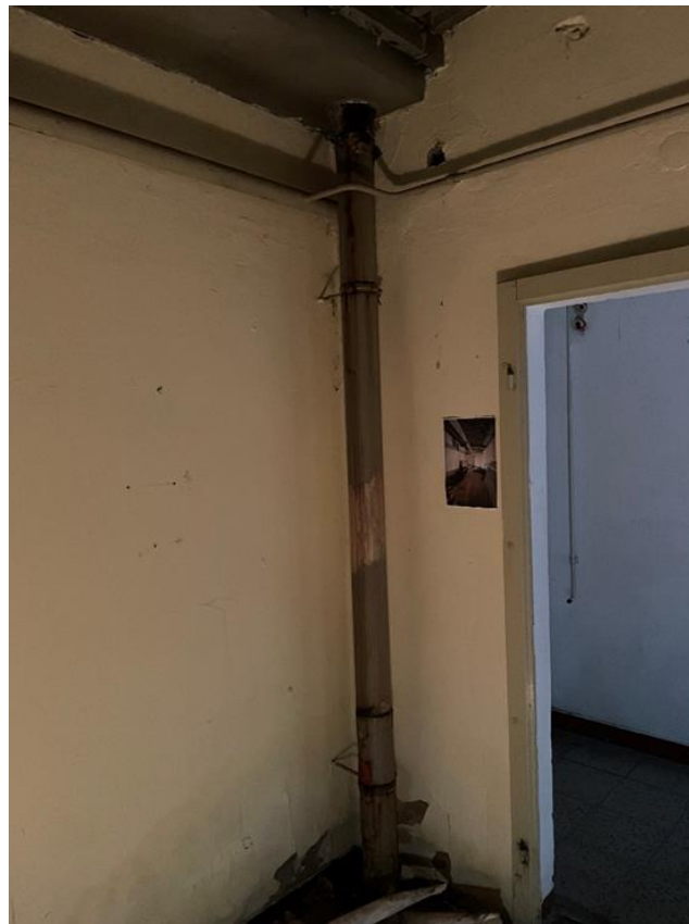
Schadhafte innenliegende Dachentwässerung
