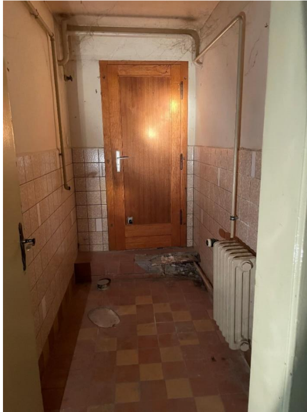
Ehemalige Außentür, außen mit Brandwand verschlossen ehemaliges WC
