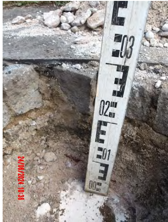
Abb. 2: Detailansicht HS 1 (Aufbruch bis zur Sperrschicht-Folie)
