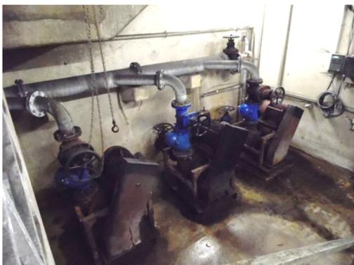
Demontage und Entsorgung von zwei trocken aufgestellten Kreiselpumpen innerhalb eines Betonbauwerks, einschließlich des vollständigen Ausbaus aller zugehörigen Rohrleitungen, Formstücke, Halterungen und Armaturen, sowie der noch vhd. stromlosen Kabel. Die Elektroanschlüsse sind bauseits bereits spannungsfrei geschaltet und außerhalb des Bauwerks abgeklemmt worden. Die Demontage erfolgt ohne Rücksicht auf das
