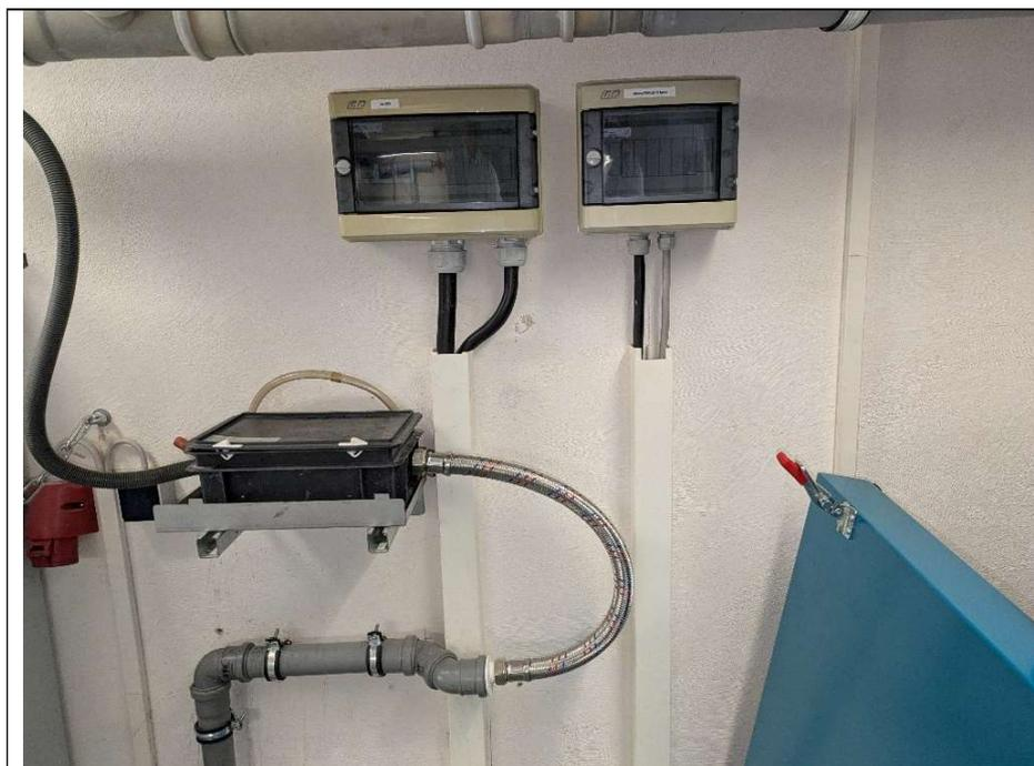
Schnittstelle für Niederspannungsanschluss und -steuerung im Hut-schienenverteiler-Heizzentrale
