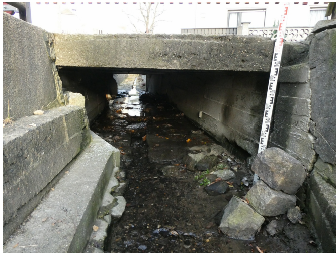
Übersicht Durchlass Unterstrom
