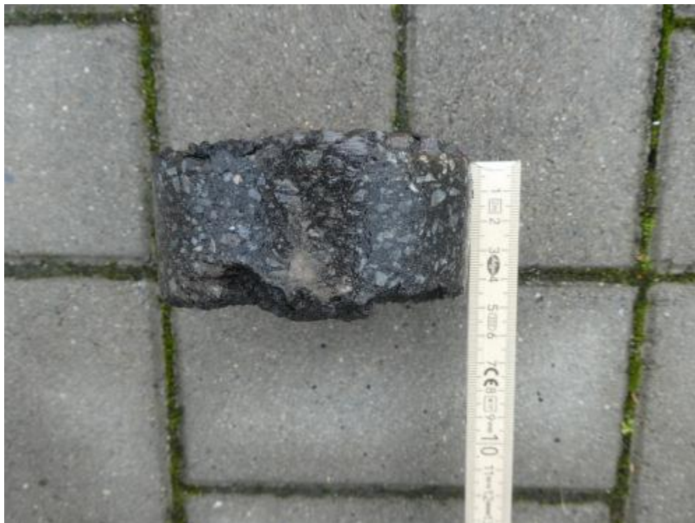
Foto 4: Asphaltbohrkern BP 04 (d=4cm) (BP 04-DPH ohne Bohrkern, da Granitpflaster)
