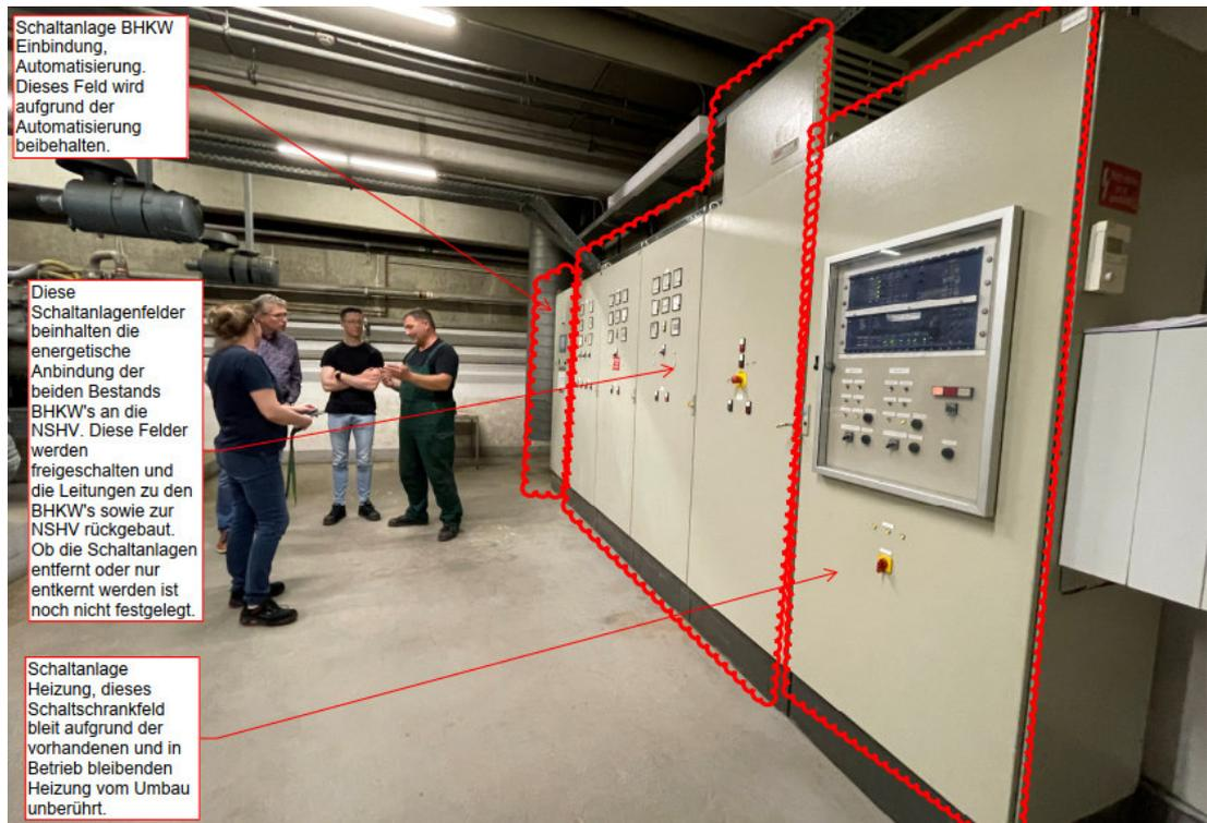
Abbildung 45; Schaltanlage zur Einspeisung ins Energienetz
