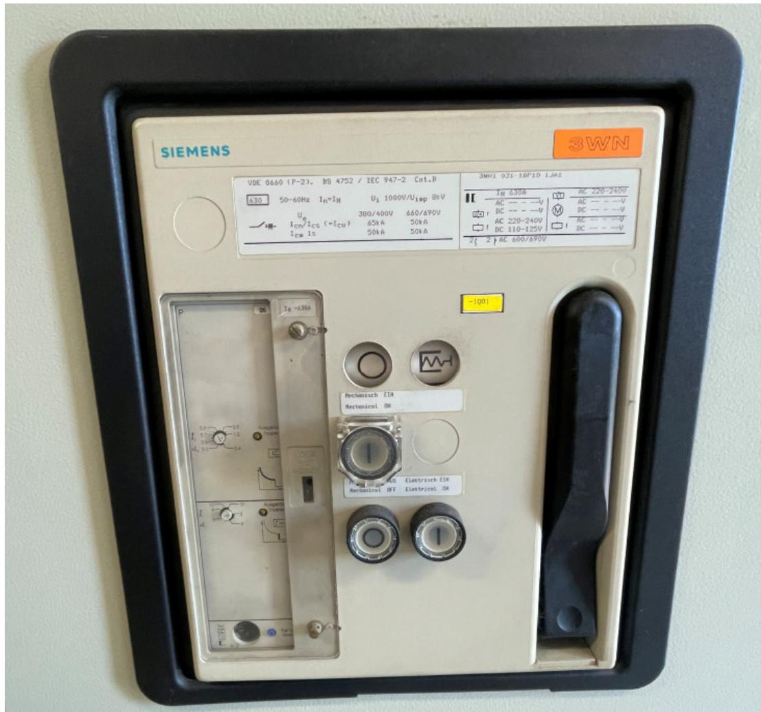
Abbildung 42; Einspeisehauptschalter 1Q10 Feld +NF04 Niederspannungshauptverteilung
