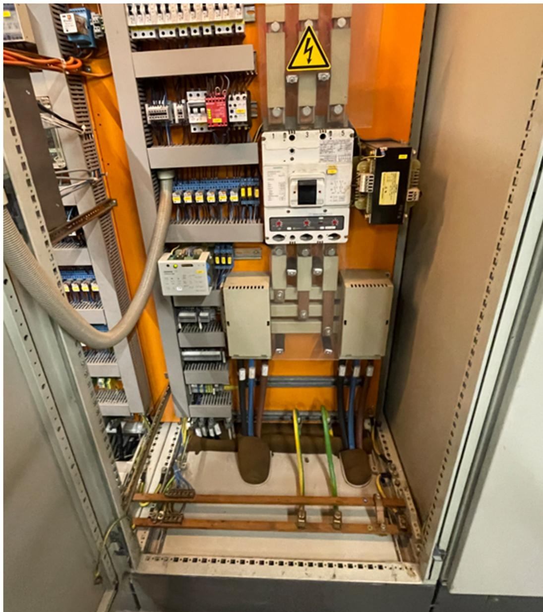
Abbildung 46: Verbindungskabel zu NSHV
