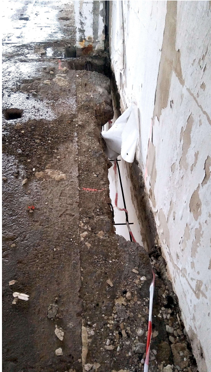
Abbildung 9: Pos. 3..10 – Sicherung von Fehlstellen, Durchbrüchen in Stahlbeton
