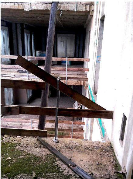
Abbildung 6: Pos. 2..10 – defekter dreiteiliger Seitenschutz zum Ertüchtigen
