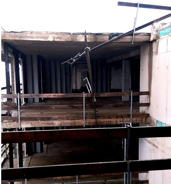
Abbildung 7: Pos. 2..10 – defekter dreiteiliger Seitenschutz zum Ertüchtigen
