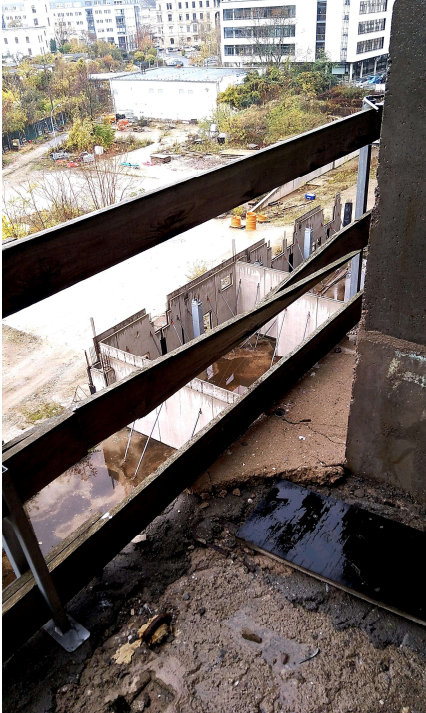
Abbildung 5: Pos. 2..10 – defekter dreiteiliger Seitenschutz zum Ertüchtigen
