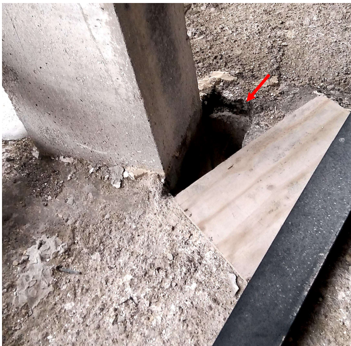
Abbildung 10: Pos. 3..20 – Sicherung von Bodenöffnungen in Stahlbeton
