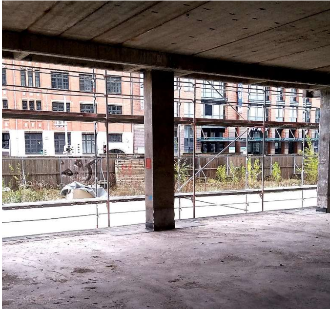
Abbildung 3: Pos. 1..10 – offener Zugang im straßenseitigen Erdgeschoss
