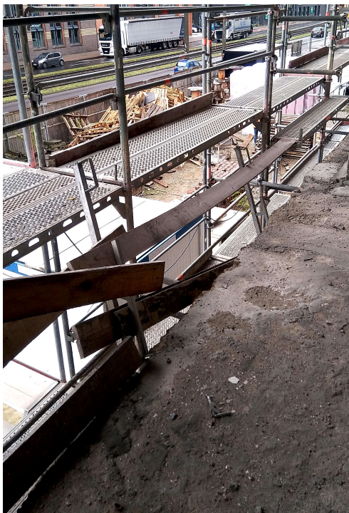
Abbildung 4: Pos. 2..10 – defekter dreiteiliger Seitenschutz zum Ertüchtigen
