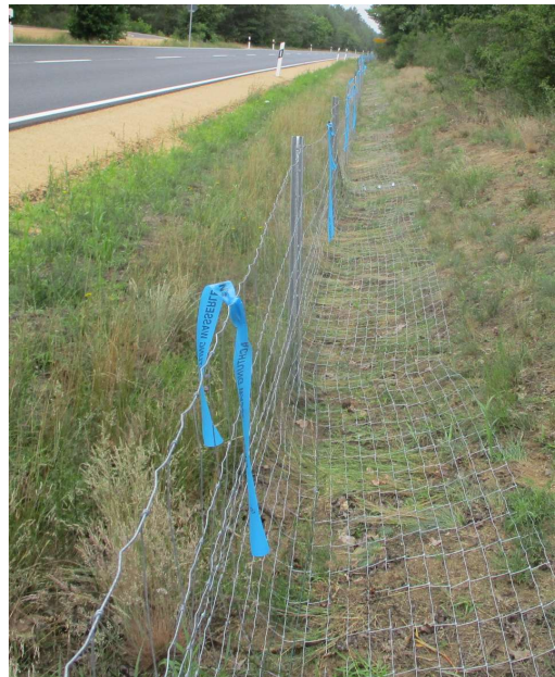
Beispiele eines aufgebauten Schutzzaunes aus Knotengeflecht parallel zur Spreestraße
