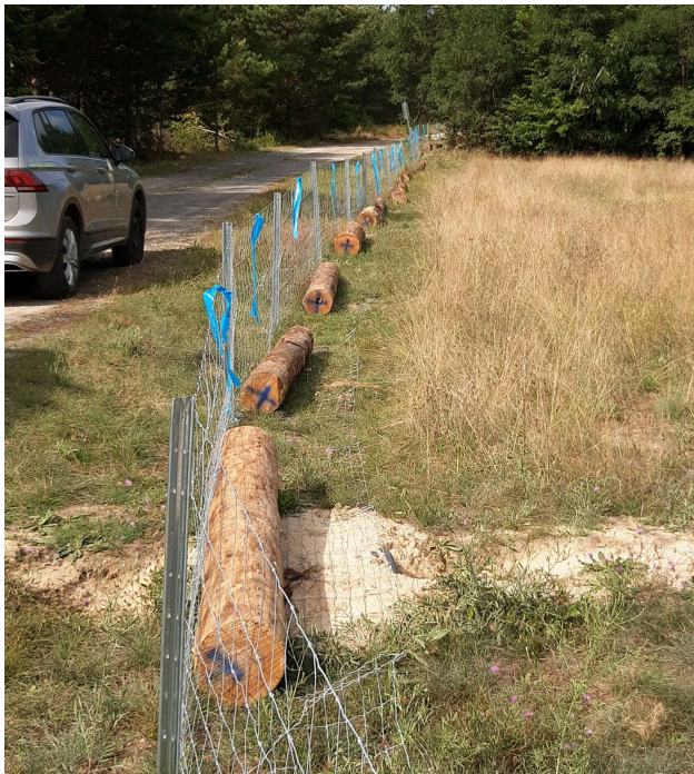
Beispiel eines aufgebauten Schutzzaunes mit Beschwerung durch Baumstämme östlich Sprey
