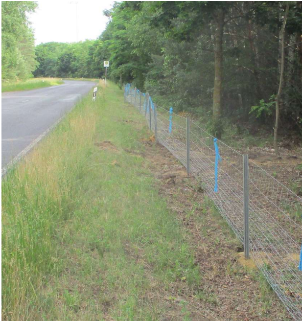
Beispiele eines aufgebauten Schutzzaunes aus Knotengeflecht parallel zur Spreestraße
