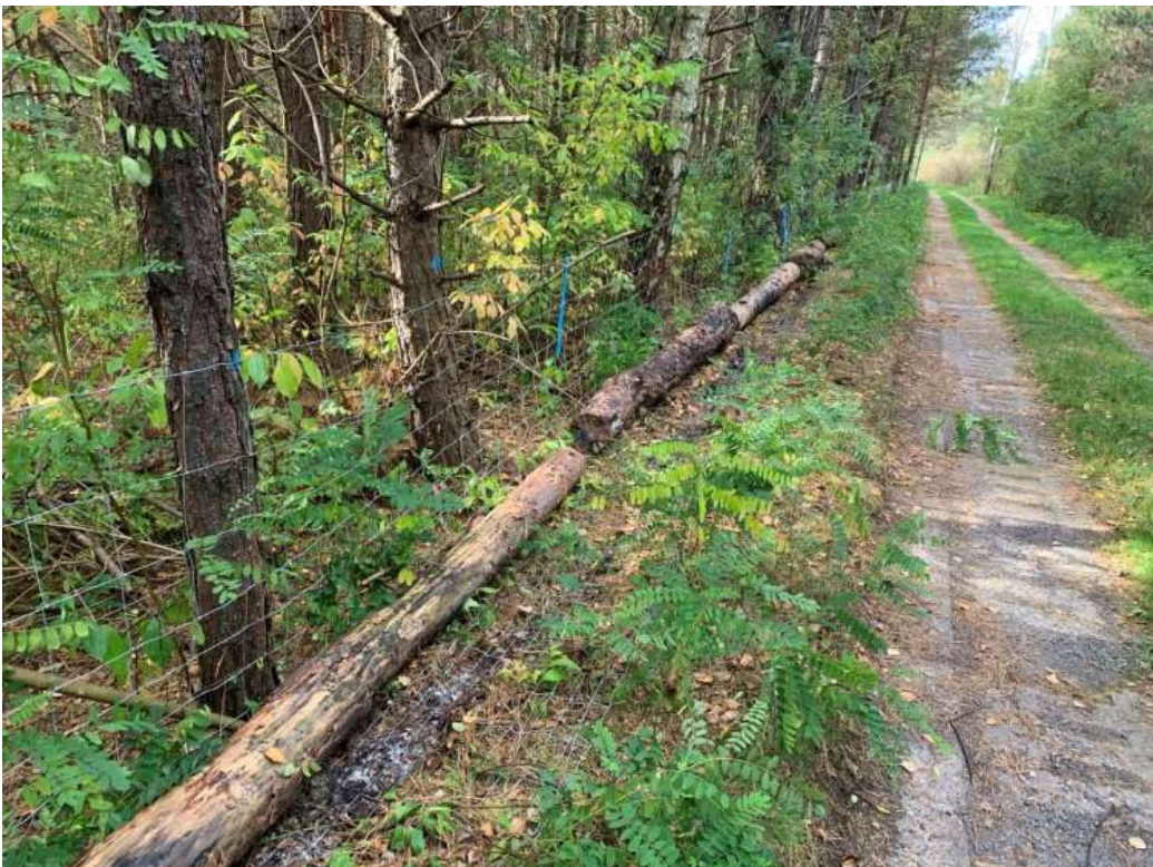
Beispiel eines aufgebauten Schutzzaunes befestigt am vorhandenen Baumbestand Höhe Ruhlmühle
