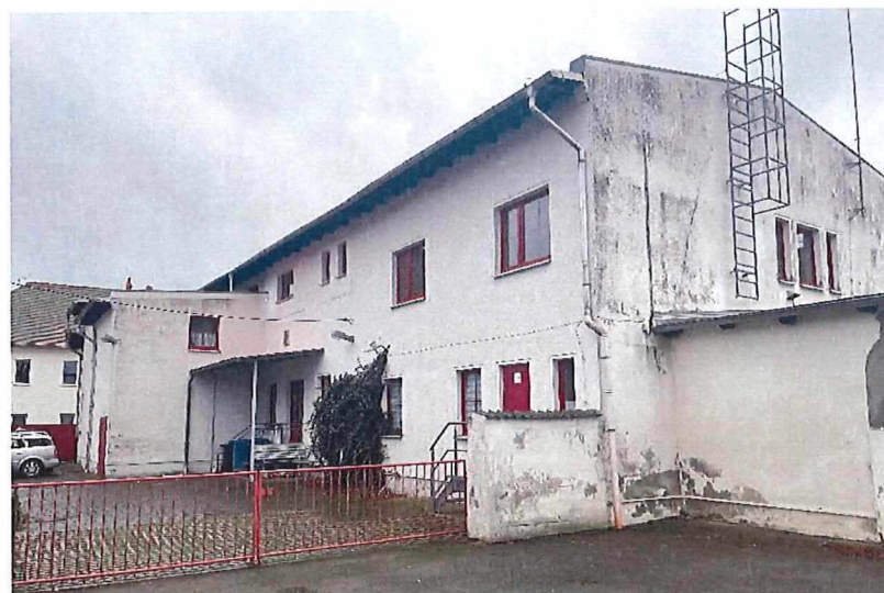
Westgiebel, Teilbereich Ansicht Nordseite (Innenhofseite)
