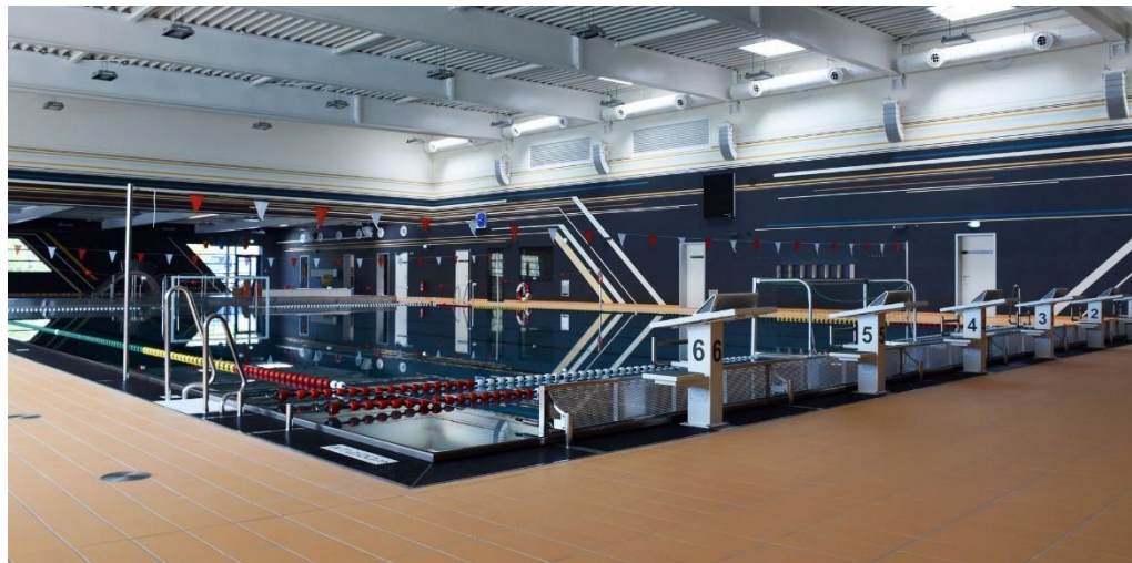
Sportbad in Dessau – Fertigstellung 2018
