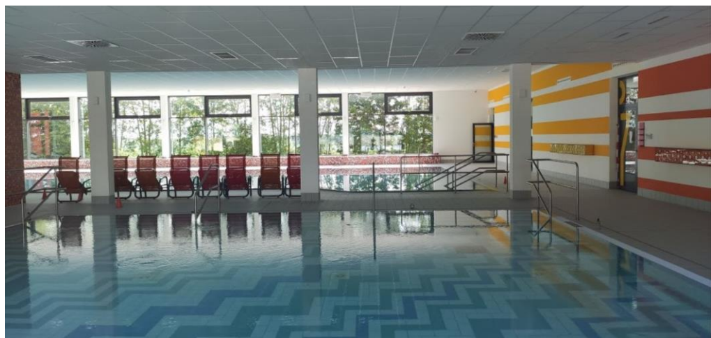
Bad am Berg in Kösching – Fertigstellung 2020
