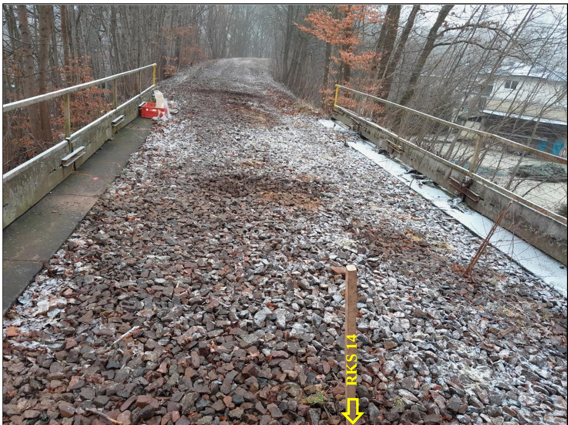
Rammkernsondierung (RKS) 14 – Ansatzpunkt
