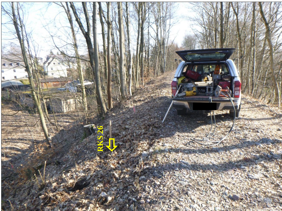
Rammkernsondierung (RKS) 26 – Ansatzpunkt
