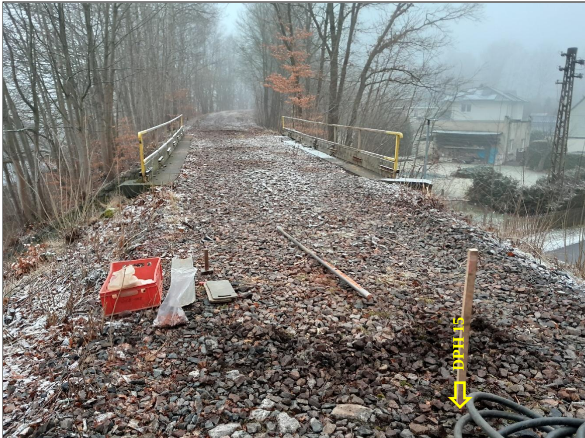
Schwere Rammsondierung (DPH) 15 – Ansatzpunkt
