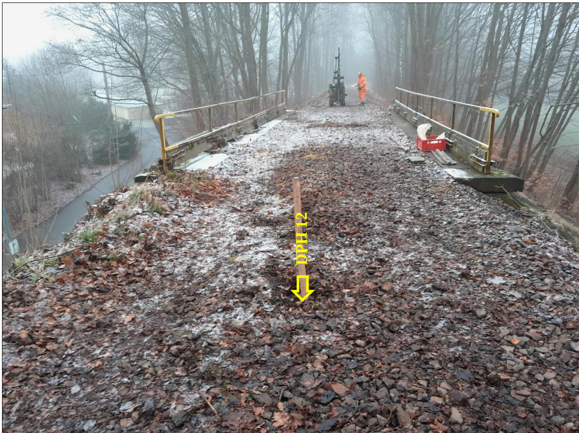
Schwere Rammsondierung (DPH) 12 – Ansatzpunkt
