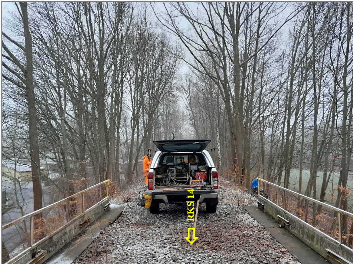
Rammkernsondierung (RKS) 14 – Ansatzpunkt
