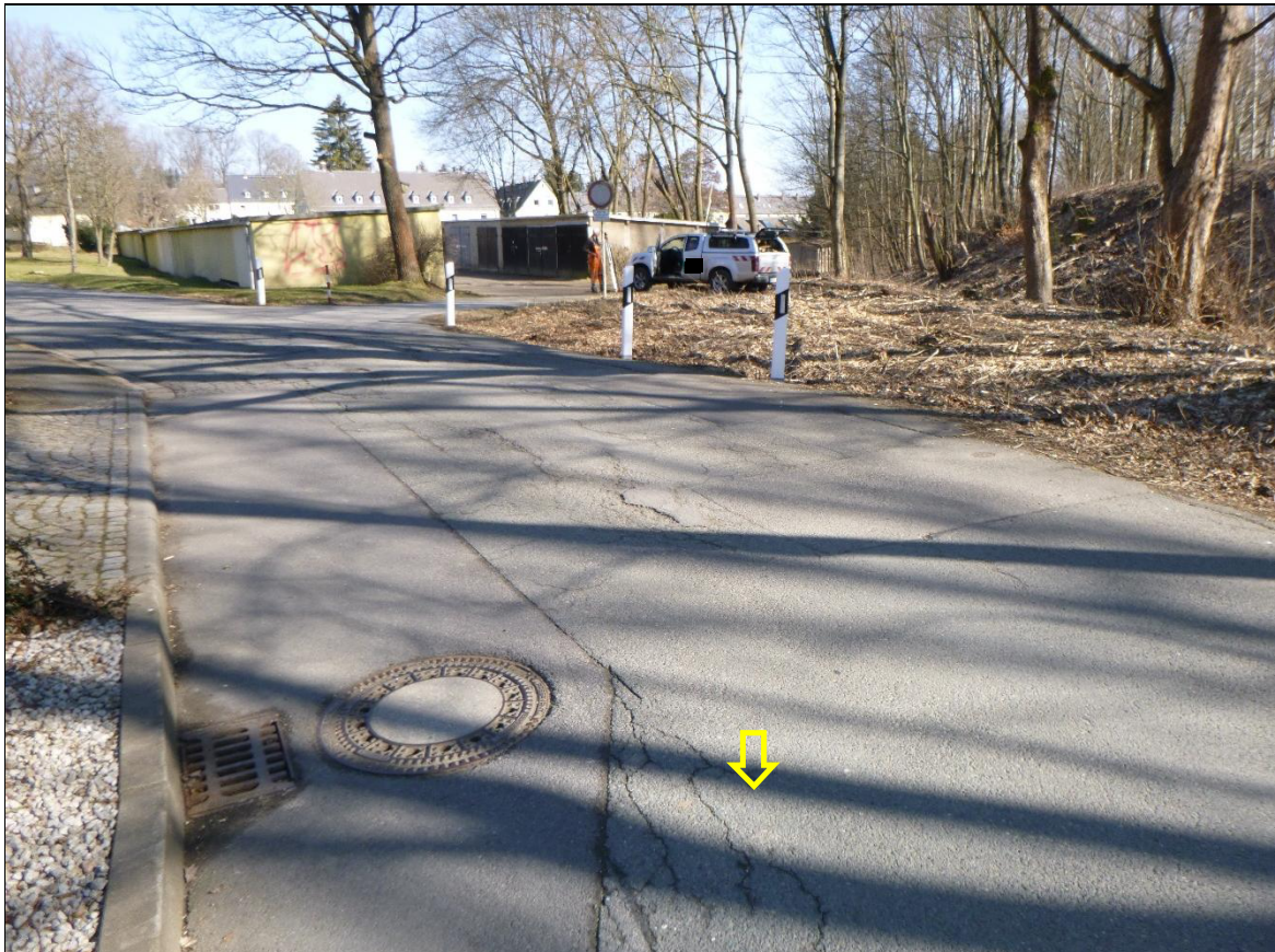
Höhenbezugspunkt (HP2) / OK Deckel = 347,26 m
