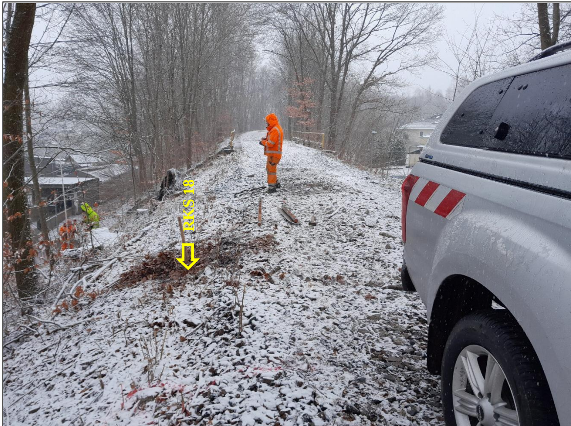
Rammkernsondierung (RKS) 18 – Ansatzpunkt
