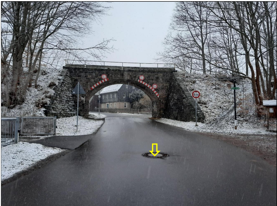
Höhenbezugspunkt (HP1) / OK Deckel = 345,99 m
