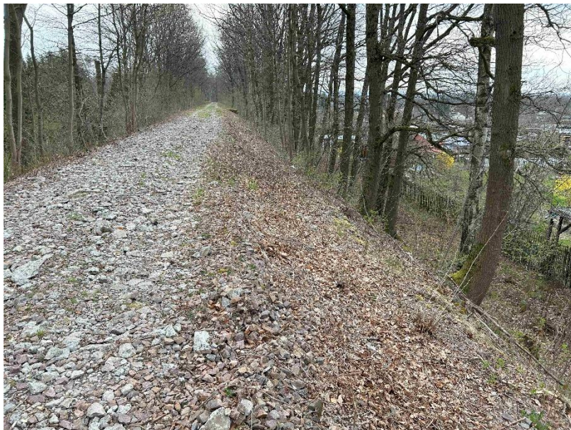
Abbildung 9: Radweg Bahndamm, zwischen Weigandstraße und Schafreiberweg, ca. Stat. 4+800, hohe Böschungshöhen erfordern Absturzsicherungen
