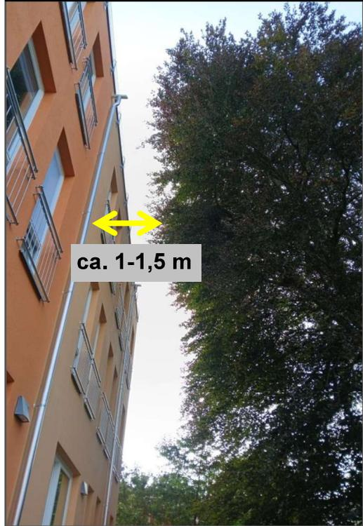
**Abb. 4.2-03:** Lichtraumprofil von 2,5 m oberhalb des Fuß- und Radweges nicht gegeben
