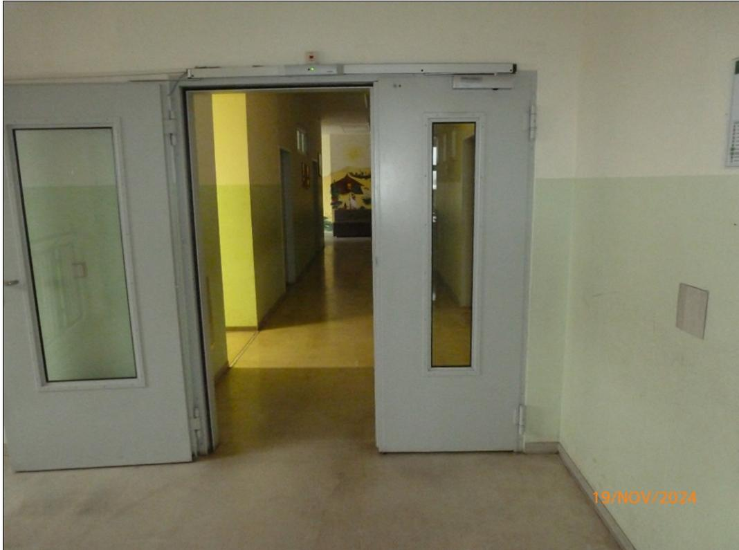
Vorhandene Rauchschutztür im Dachgeschoss, Rückbau nach Pos. 3.2.4
