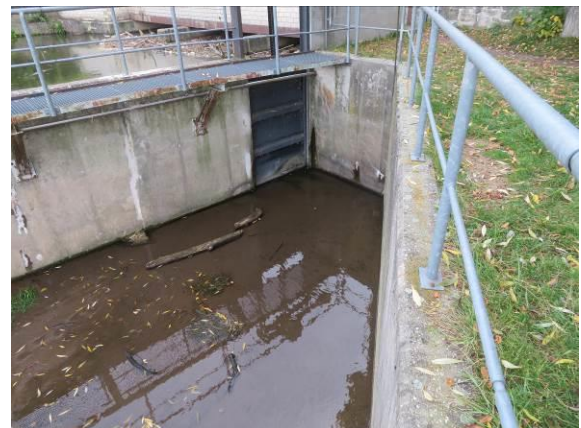
Blick nach Nordosten auf Bypassschieber
