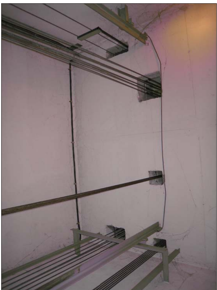
Ansicht Schachtkopfdecken z. Maschinenraum
