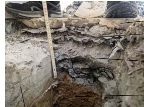
Detail: Fußbodenaufbau / Anschluss an Fundamente
