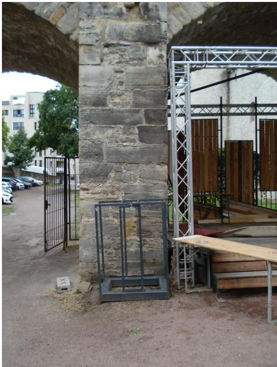
Abbildung 8: Burgbrücke Pfeiler 2 © Kulturstiftung Sachsen-Anhalt
