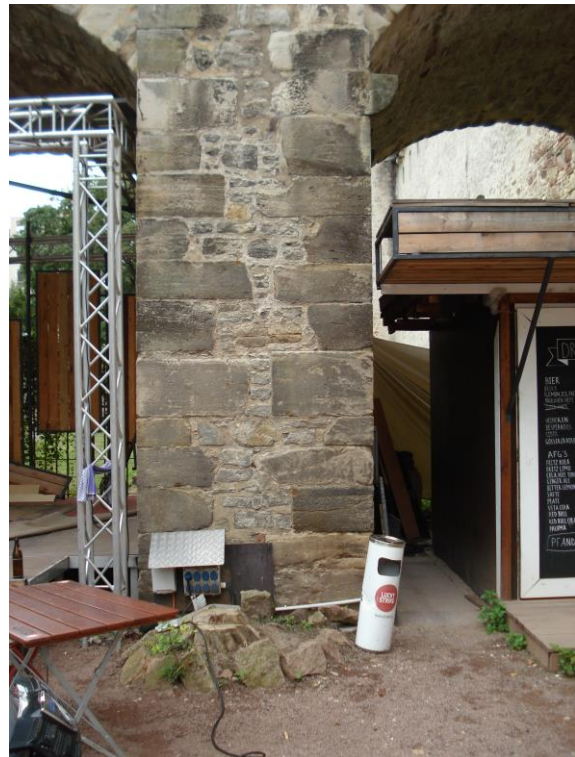
Abbildung 9: Burgbrücke Pfeiler 3 © Kulturstiftung Sachsen-Anhalt
