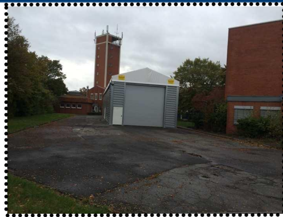
Leichtbauhalle und Schlauchturm
