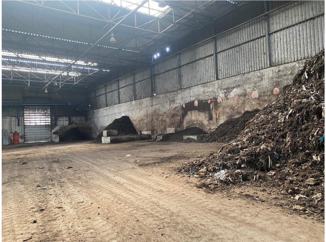
Bild 2-3: Aufstellbereich in der Nachrottehalle
